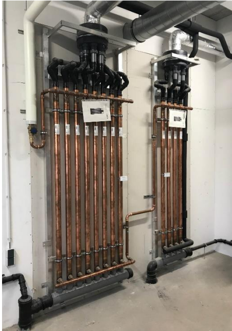
Figuur 19: Douchewarmtewisselaars in de sporthal "Zeeburgereiland", Lomans Amersfoort, Foto: Technea
