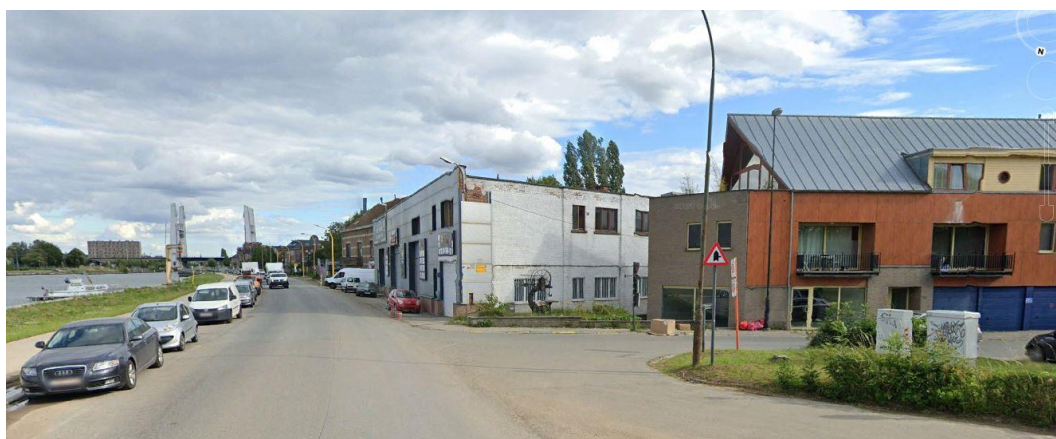
Vanaf de Jan Jozef Engelgomstraat naar de Verbruggestraat – verwaarloosde loods-garage, rechts de nieuwbouw
