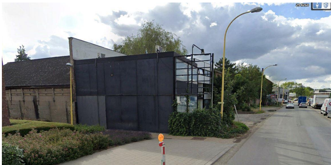
Vanaf de Verbruggestraat richting verbrande Brug – leegstand, onderbenutte gebouwen
